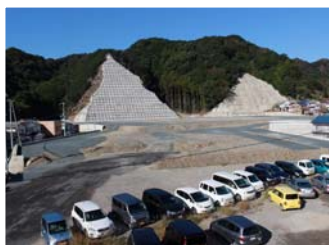
消防本部から撮影した建設地
