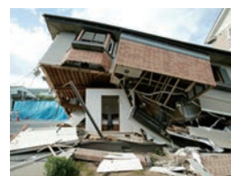
※耐震シェルターの一例
