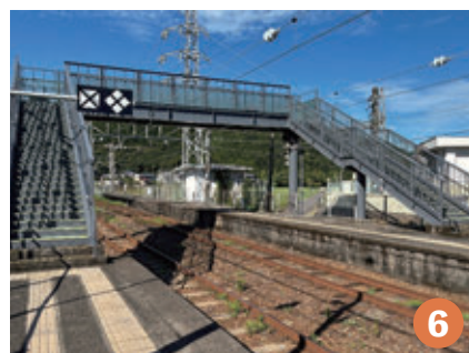
⑥ 58 段ある駅の陸橋を昇り降りすることで下半身の筋力強化も期待できます。ここを過ぎると間もなく到着です。
