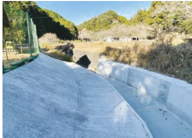
河川改修工事（井鹿川）
