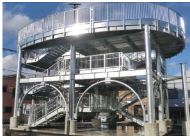
下里地区津波避難タワー
