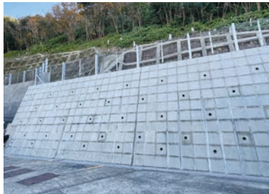
急傾斜地崩壊対策事業（湯川地区）
