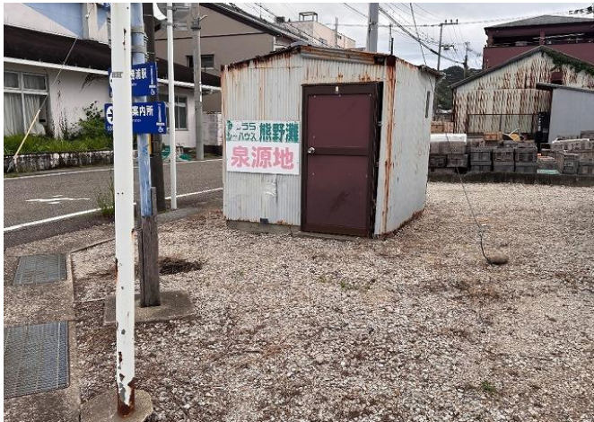
泉源ポンプ室
