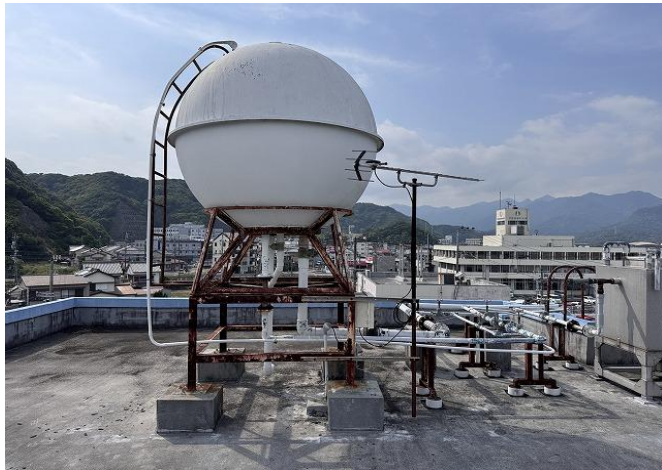
屋上（高架水槽）
